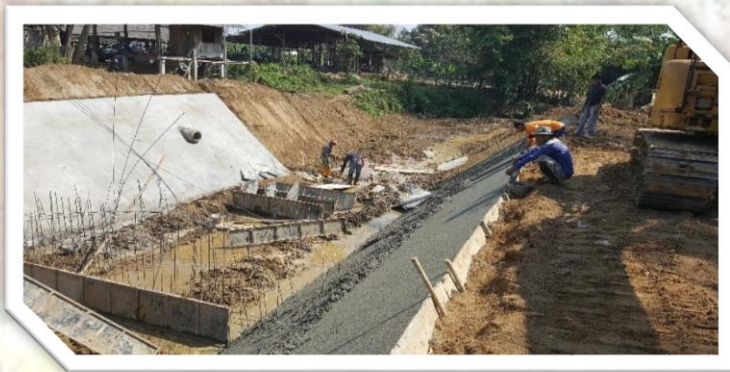
ดำเนินการแล้วเสร็จ
